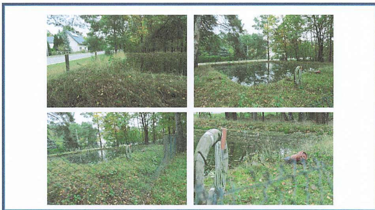
Abbildung 2: Feuerlöschteich im nordwestlichen Grundstücksbereich
