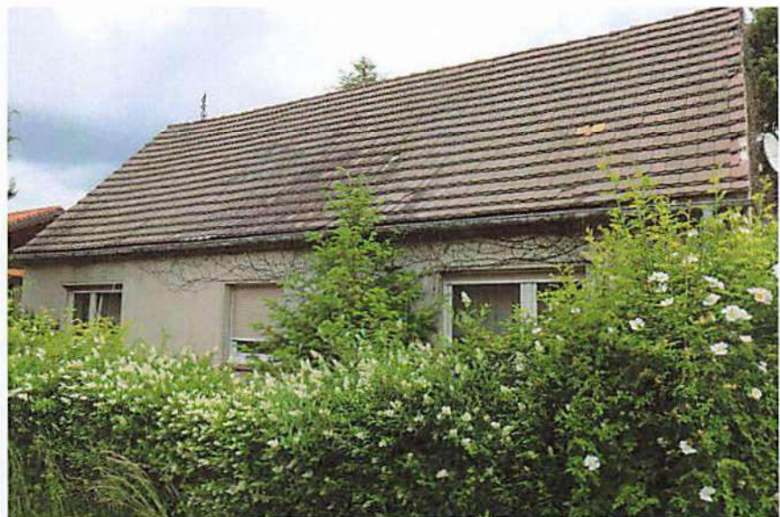
Fehlstellen in der Dachfläche / Verformungen
