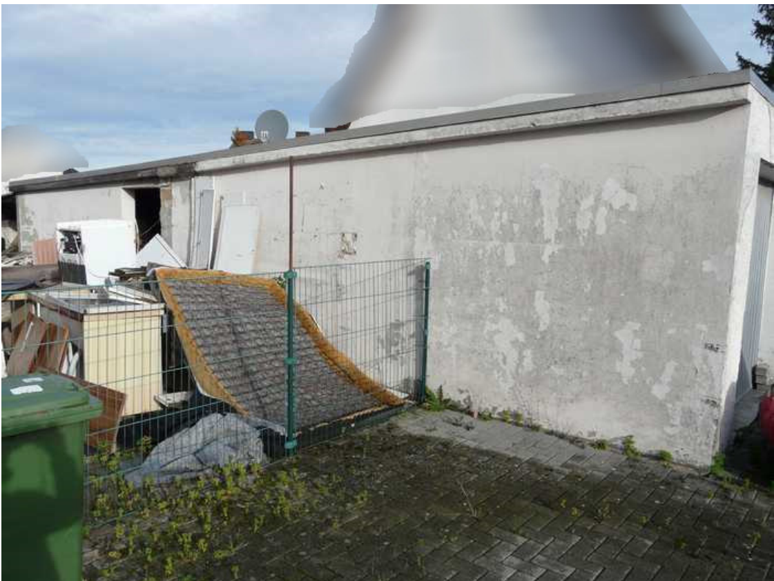
Ansicht von Süden (Garage)
