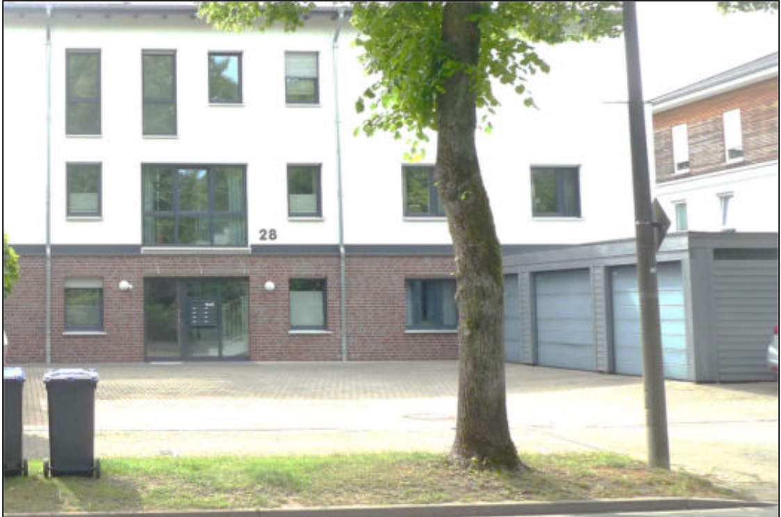
Abbildung 45 Hauszufahrtsbereich auf dem Grundstück mit dem Wertermittlungsobjekt fotografiert am 04.06.2025
