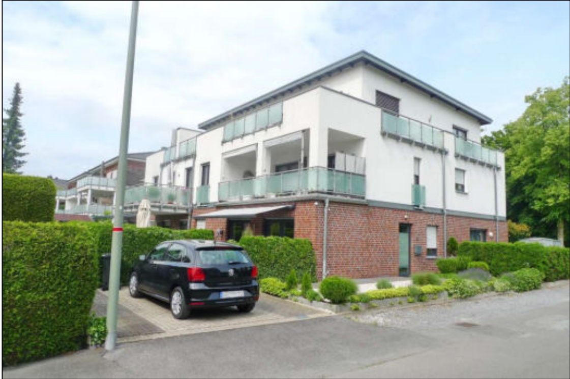
Abbildung 10 Rück- und Seitenansicht der baulichen Anlage Wohnhaus fotografiert am 04.06.2025
