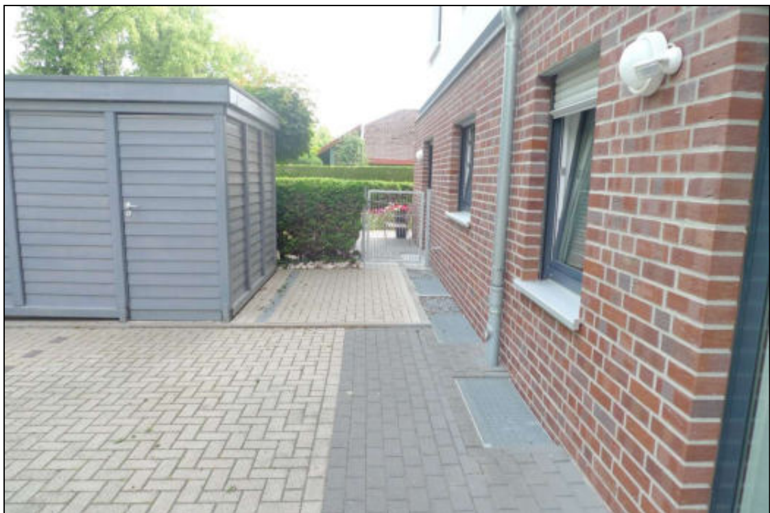
Abbildung 48 Zugang zum als Spielplatz ausgewiesenen Bereich auf dem Grundstück mit dem Wertermittlungsobjekt fotografiert am 04.06.2025
