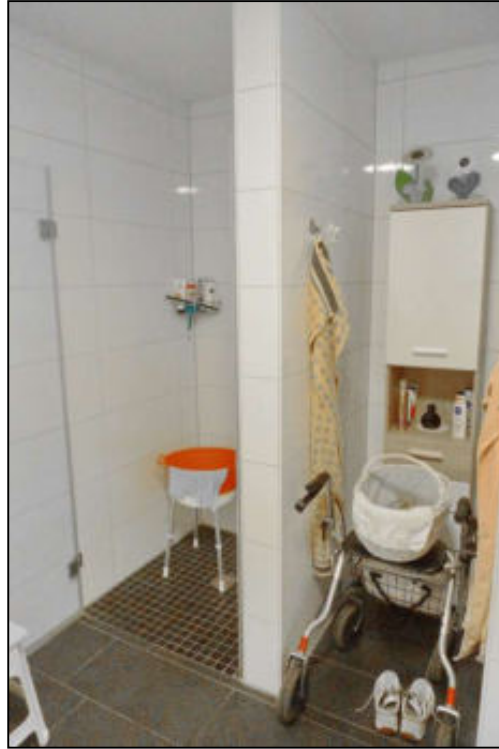
Abbildung 35 bodengleiche Dusche im Bad der Wohnung Nr. 6 fotografiert am 04.06.2025
