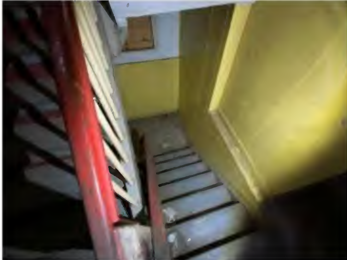
Bild 16: Treppe 2. OG - DG
